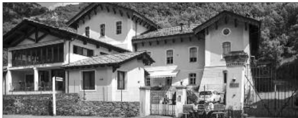
La casa di riposo "A. Riberi" di Stropo
