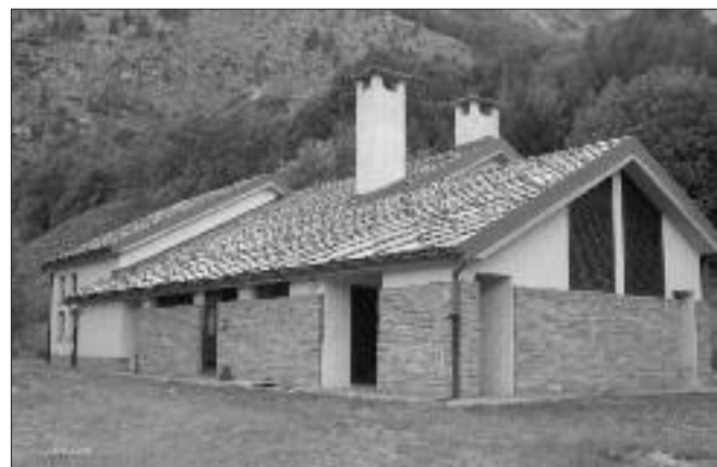
La centralina idroelettrica a Chiappera
