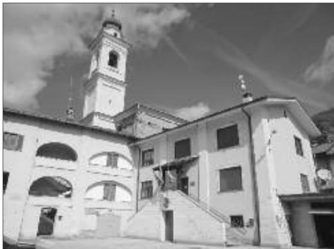
La sede dell'Unione Montana a San Damiano Macra
