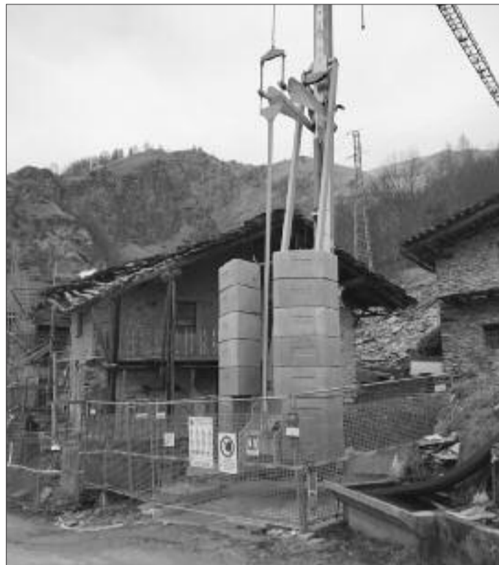
Nelle foto, alcuni dei cantieri avviati ad Elva
