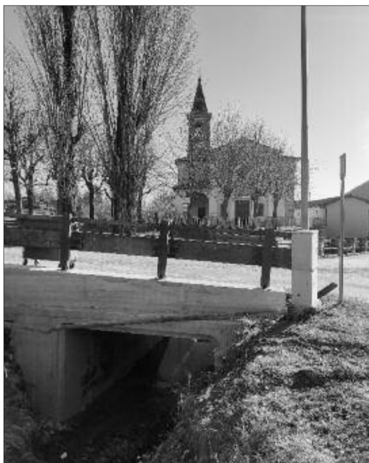
Il nuovo ponte sul bedale di Foglienzane (rio Garino)
