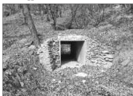
L'intervento di attraversamento del rio a B.ta Centro
